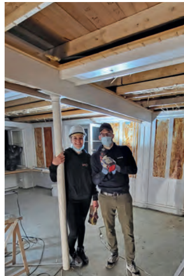
Im März wurde die Deckenisolation entfernt. Bild: zvg
