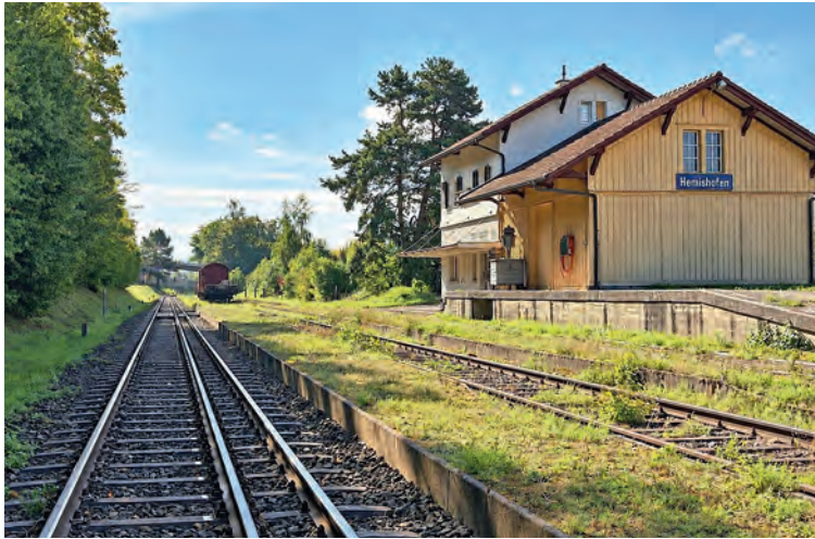
Die Teststrecke zwischen den Bahnhöfen Hemishofen und Ramsen wurde mit einer dritten Schiene auf Schmalspur umgerüstet.
