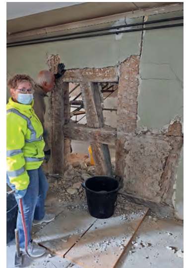
Vor wenigen Tagen wurden Wände durchbrochen. Bild: zvg
