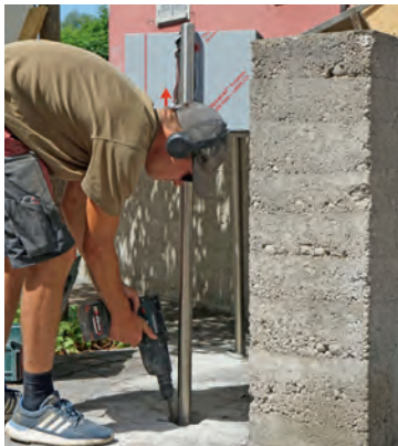
Godwin Kern betoniert einen Briefkasten ein und achtet dabei, dass er im Lot ist. Bild: mhr
