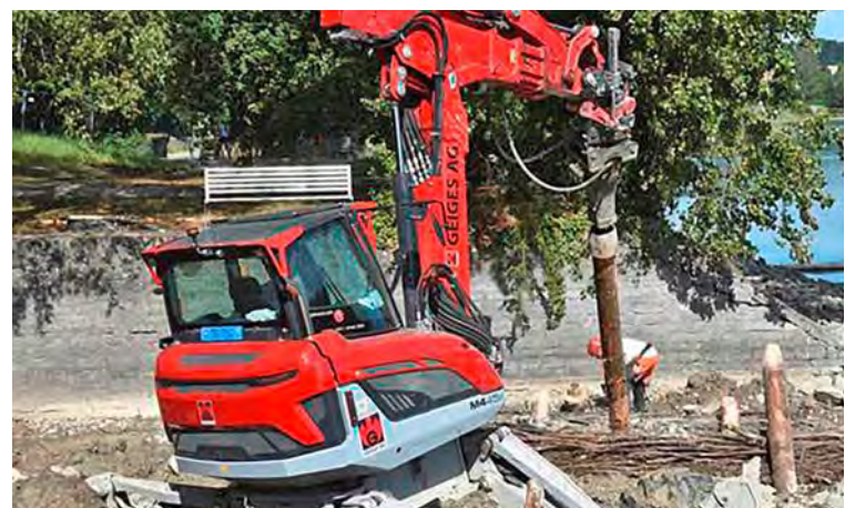
Die Bauarbeiten für das Kaltwasserrefugium.
