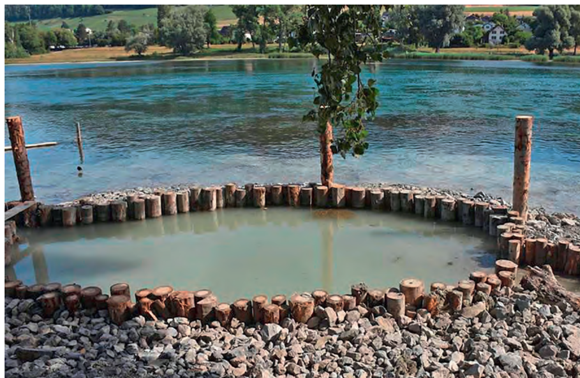
Um die Überlebenschancen der Äsche zu erhöhen, wurde an der Mülibachmündung in Wagenhausen ein Kaltwasserrefugium gebaut.
