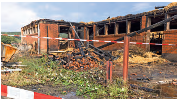
Die Scheune bestand hauptsächlich aus Holz und einigen wenigen Stahlkonstruktionen.
