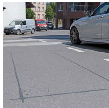
So erkennt die Steuerung, ob Fahrzeuge an dieser Stelle fahren oder warten.
