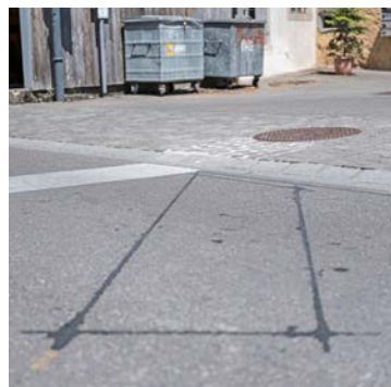
Fahrzeuge oder Velos verändern das Magnetfeld, wodurch ein elektrisches Signal ausgelöst
