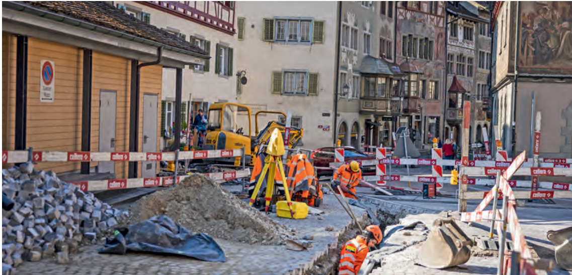
Beim Chirchhofplatz wird die Lichtsignalanlage beim durch den Kanton ersetzt.
