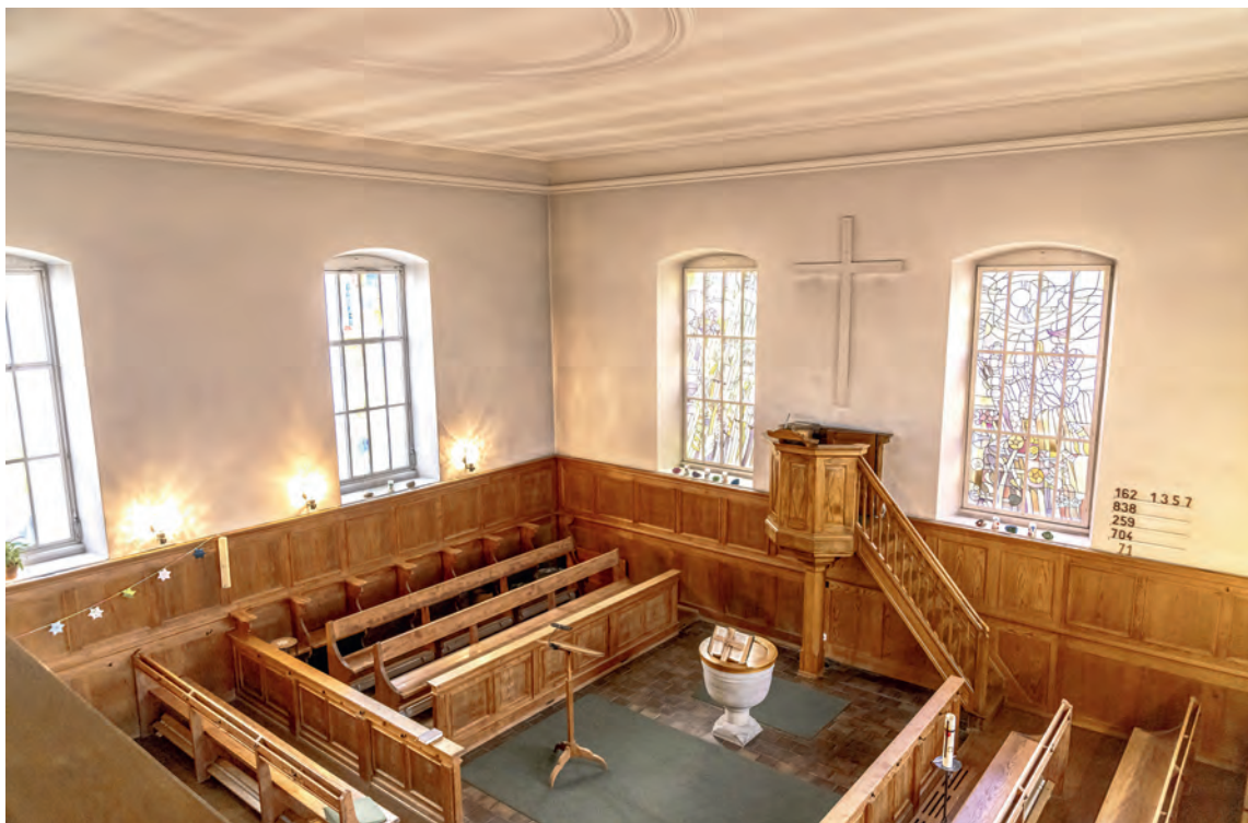
Die Sanierung der evangelisch-reformierten Kirche in Ramsen soll nicht nur der baulichen Erhaltung dienen, sondern auch die zukünftige Nutzung der Kirche berücksichtigen.
