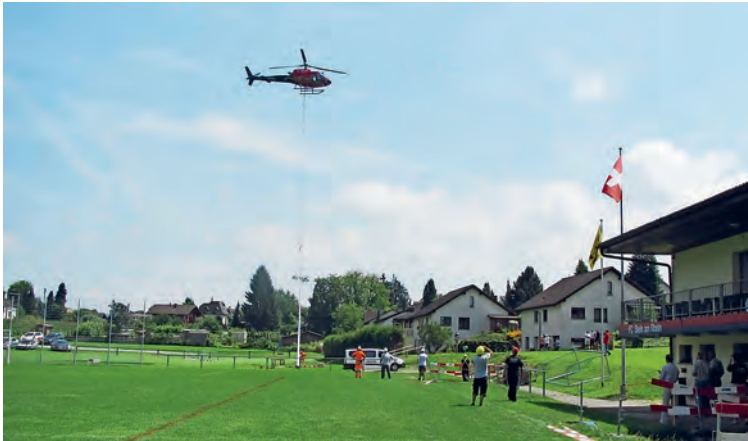
2014 wurden die Beleuchtungsmasten mit Helikoptern gesetzt. Bild zvg
