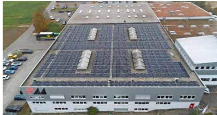
Rund 230 000 Kilowattstunden Strom werden bei Phoenix Mecano in der vor Kurzem in Betrieb genommenen PVA produziert. Bild zvg
