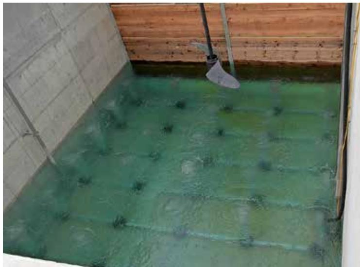
Blick in das sechs Meter tiefe Becken für biologische Abwasserreinigung mit Rührwerk, Bodenbelüfter und Trennwand aus Eschenholz. Bild: hjw
