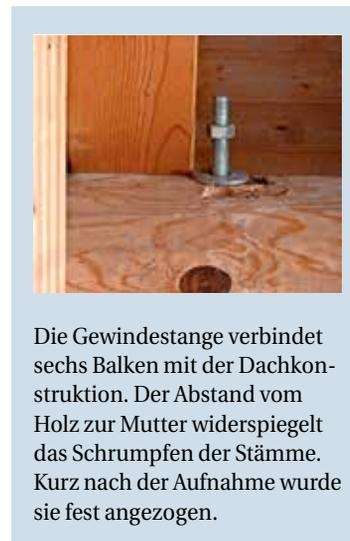
Die Gewindestange verbindet sechs Balken mit der Dachkonstruktion. Der Abstand vom Holz zur Mutter widerspiegelt das Schrumpfen der Stämme. Kurz nach der Aufnahme wurde sie fest angezogen.
